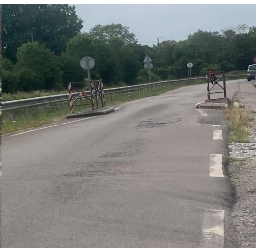
Photo voirie Rue de la Battellerie
