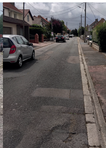
Photo voirie Paul Doumer
