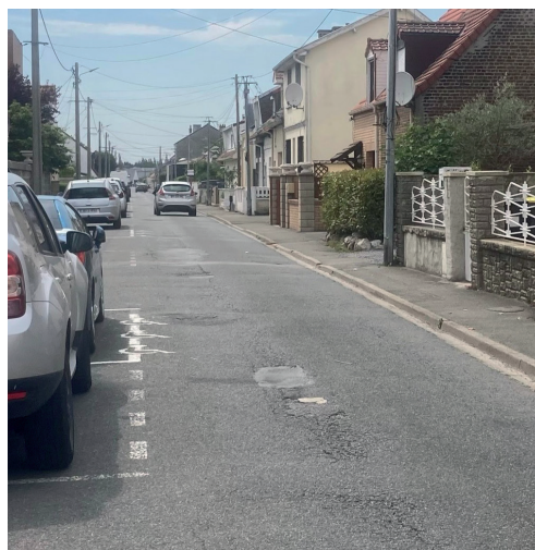
Photo voirie Rue de Verdun
